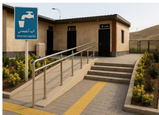
تصویر ۱۷- نمونه پیشنهادی رمپ استاندارد با عرض مناسب، دستگیره دوطرفه و کف پوش ضدلغزش جهت عبور ایمن افراد دارای ناتوانی جسمی.
