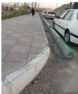
تصاویر ۲-۳-۴- ورودی پیاده‌روها و پارک فاقد رمپ؛ مانع جدی برای ورود ویلچر و کالسکه
