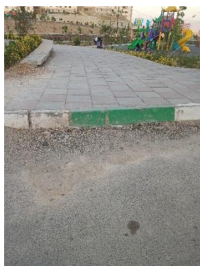
تصاویر ۲-۳-۴- ورودی پیاده‌روها و پارک فاقد رمپ؛ مانع جدی برای ورود ویلچر و کالسکه
