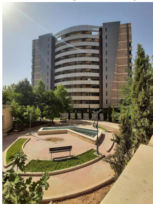
تصویر ۱. ضلع شمال غربی ساختمان
