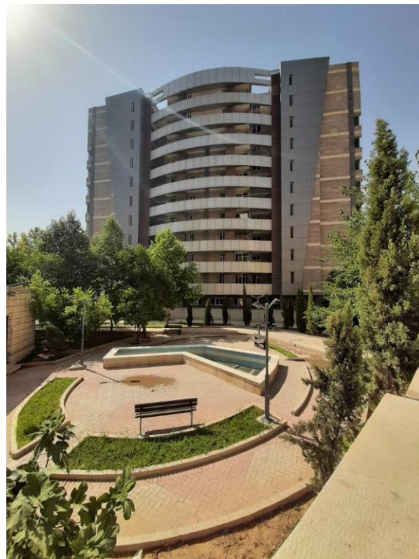
تصویر ۱. ضلع شمال غربی ساختمان
