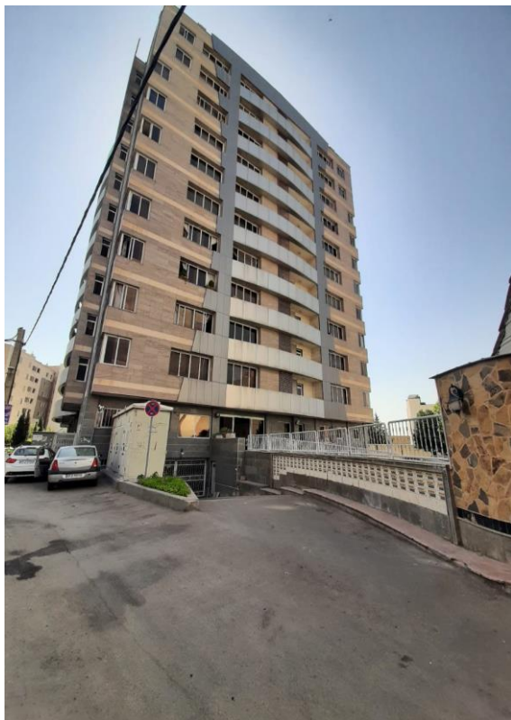
تصویر ۲. ضلع جنوب غربی که سمت معبر و ورودی به محوطه حیاط ساختمان است
